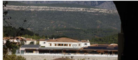
À l'école La Roque Martine, des panneaux photovoltaïques ont été installés pour rendre le bâtiment autonome en énergie. / PHOTO S.D.
