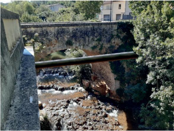
À partir de novembre 2024 pour une durée prévisionnelle de 5-6 semaines, va débuter la phase 2 de ces travaux, ils concernent le renouvellement des réseaux publics d'eau potable et d'eaux usées vétustes (*et fuyard pour celui de l'eau potable*) situés en encorbellement sur le pont du Réal dit « Guillot ».
